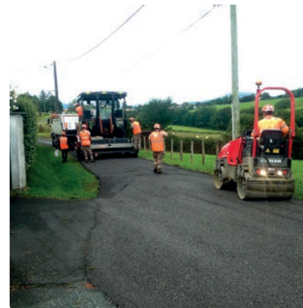
BIRGALENEA : Pose de grave émulsion au finisseur et création-curage de fossés
