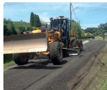
BUZTIN KARRIKA : Grave émulsion et gravillonnage bicouche
