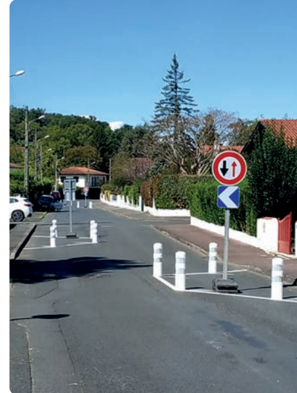
RUE DES MONTAGNES : sécurisation par 2 écluses avec priorités inversées obligeant à ralentir
