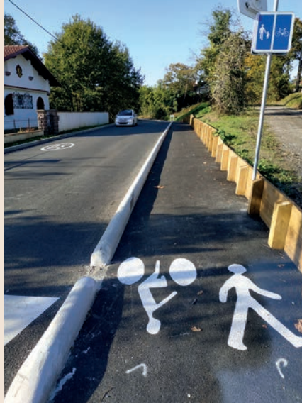
RD 350 : Première tranche de la voie cyclable reliant le fronton d'Arruntza à Bordaberria en passant par Narbea.
