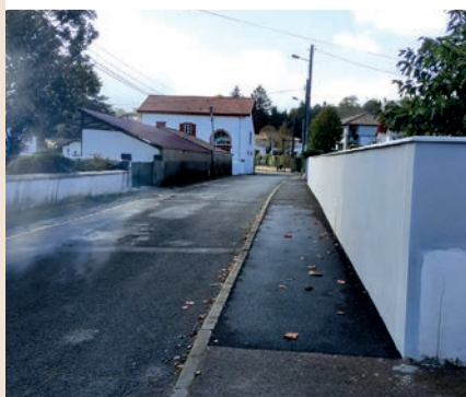
RUE KIROLETA : Mise aux normes Personnes à Mobilité Réduite d'un tronçon de trottoir.
